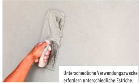
Der Werk trockenmörtel wird auf der Baustelle nur mit Wasser gebrauchsfertig gemacht.
