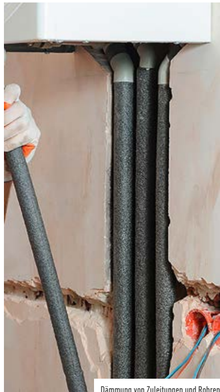
Dämmung von Zuleitungen und Rohren
