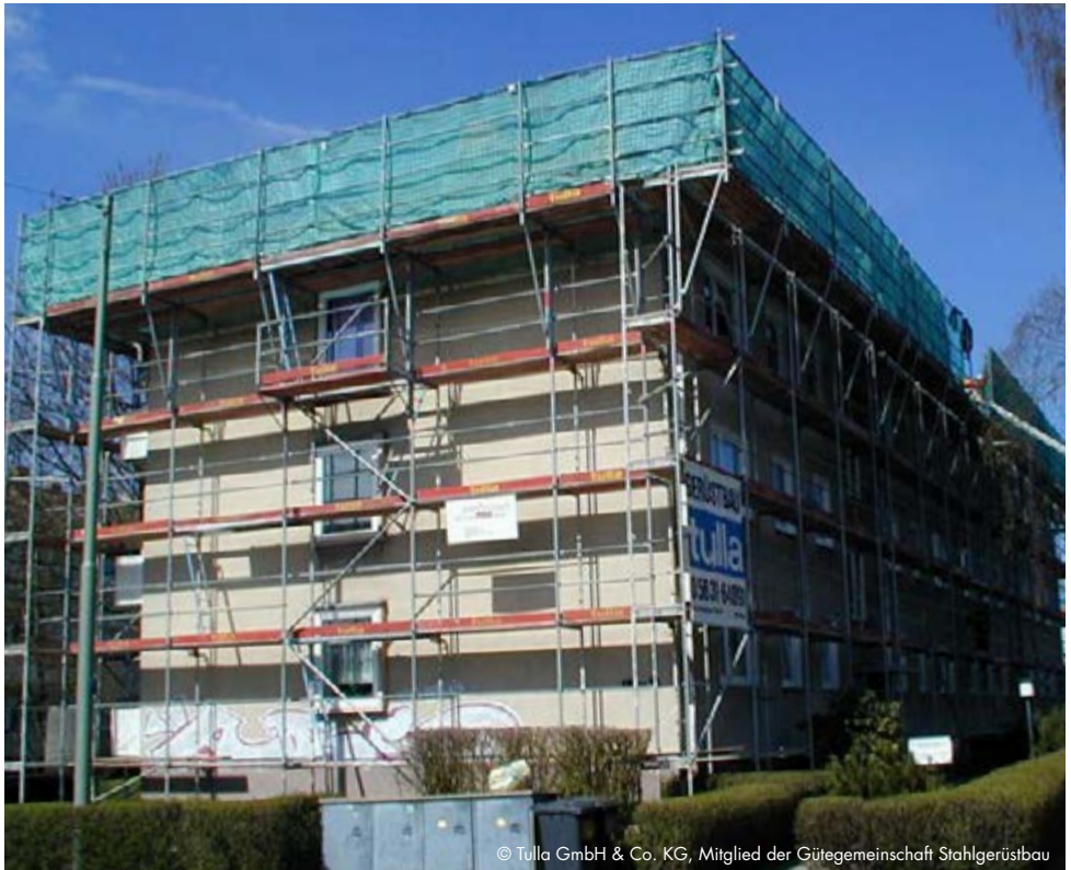
© Tulla GmbH & Co. KG, Mitglied der Gütegemeinschaft Stahlgerüstbau
